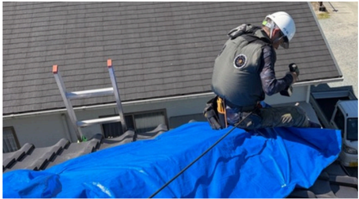
関係機関と連携・調整のもとで行った屋根被害への応急対応
