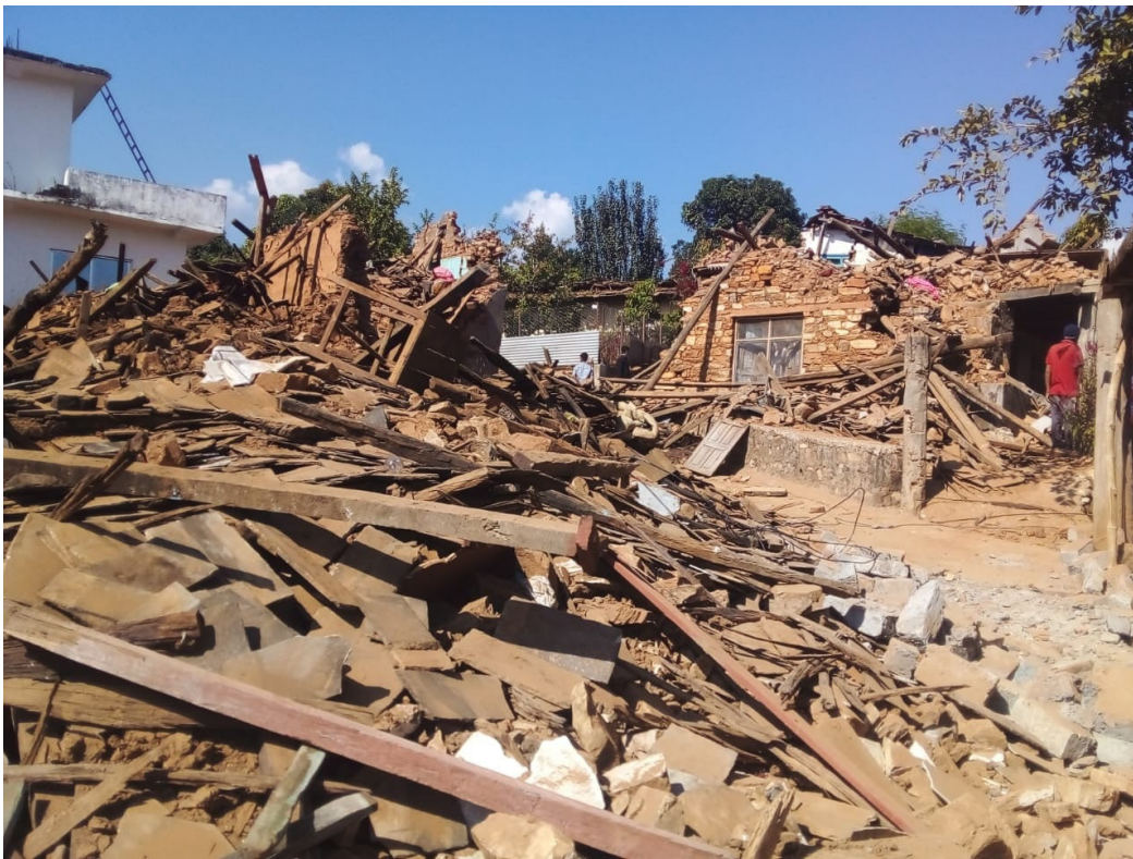
ネパールの丘陵地帯でM6.4の地震。家屋の倒壊や土砂崩れが多数発生している。（撮影：2023年11月5日 ジャジャルコット郡）
