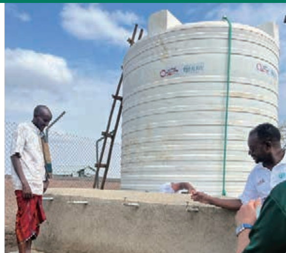
約4,000人が利用できる給水タンクを設置。
