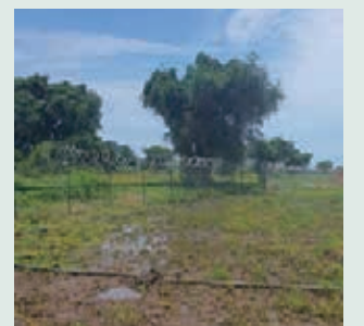
農地に設置されたフェンスと灌漑用のパイプ。
