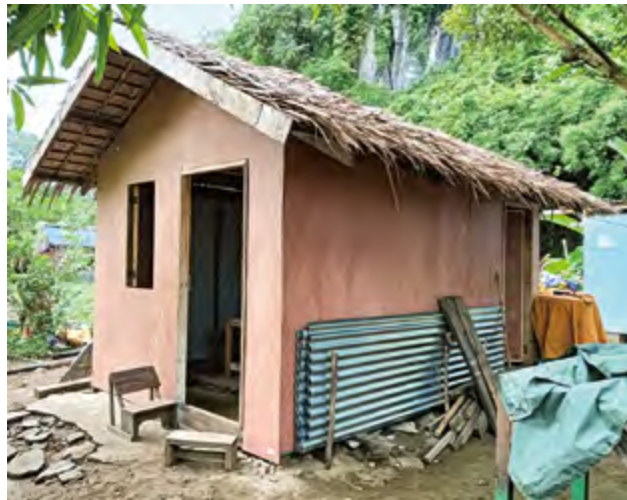
壁の修復を終えた家。今後トタンを屋根に取り付け、再び暮らせる住まいへと整えていく。
