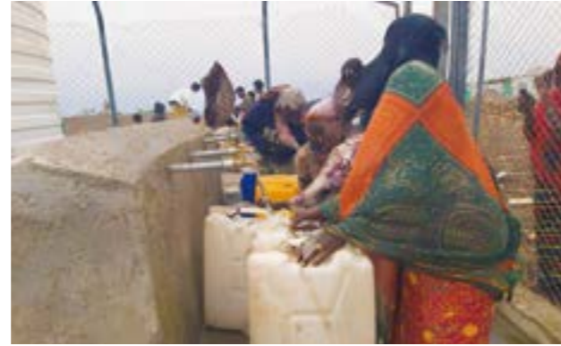
修繕された給水所から水をくむ人々。約800世帯が安全な水を手に入れることができています。
