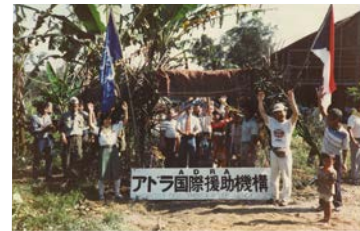
1988年、時代に先駆けてマレーシアに学生ボランティアを派遣し、井戸6本掘削
