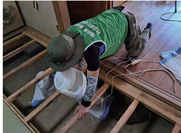
床下にサーキュレーターを設置する東峰村社会福祉協議会職員
