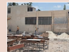
学校の修復支援も実施している
