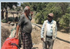
ポンプ(写真左下)を使って水を井戸からくみ上げ、畑に水を引く灌漑を修復
