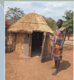
難民の方が自らの手で設置したトイレ。屋外排泄による感染症まん延の危険から自分たちの住環境を守ることができる。
