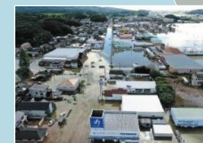
浸水被害をうけた佐賀県武雄市
