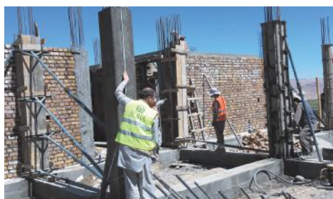
現事業の学校建設現場
