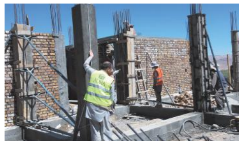
現事業の学校建設現場
