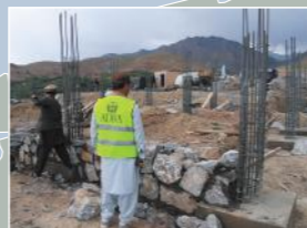
校舎の基礎工事を開始
