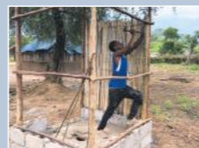
建設経験のある難民によるトイレ建設
