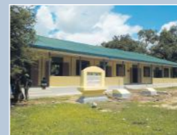
建設した新校舎
