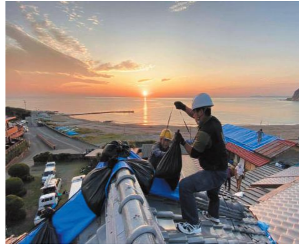
技術ボランティア団体による屋根応急処置
