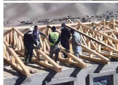
(上) 校舎の土台作りを開始 (下) 校舎の屋根を建設
