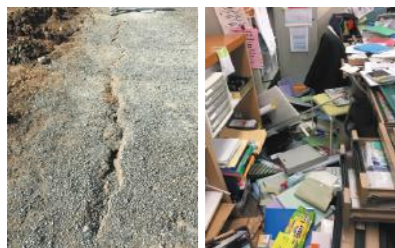
被災状況(震度7を観測した地域もあった)
