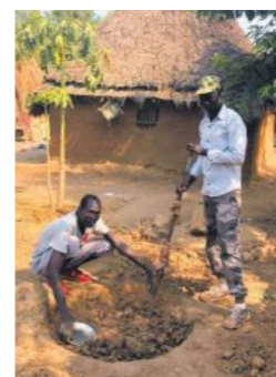
(上) トイレを設置する穴の掘削(右) トイレ建設。壊れても住民が直しやすいよう木や竹を利用するようにした
