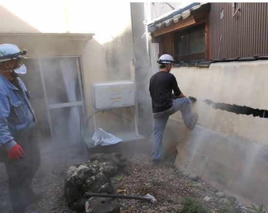
壊れた塀の撤去などは、専門的な技術が必要になる
