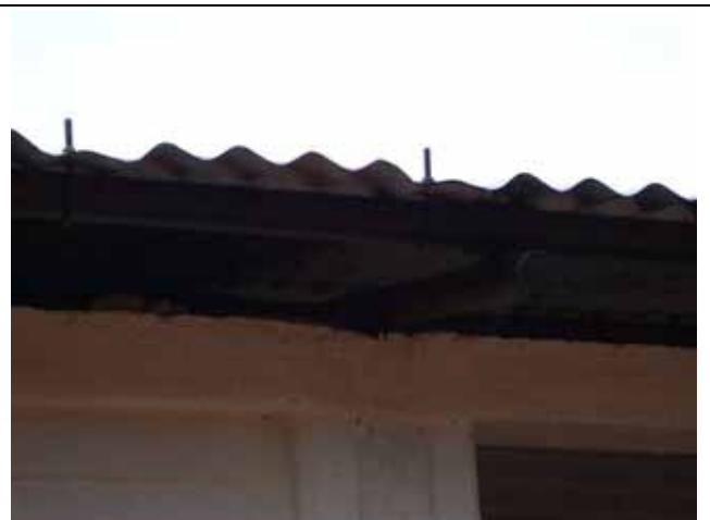
屋根材には、さび止めコーティング（黒色の塗料）を施した（全地域共通）
