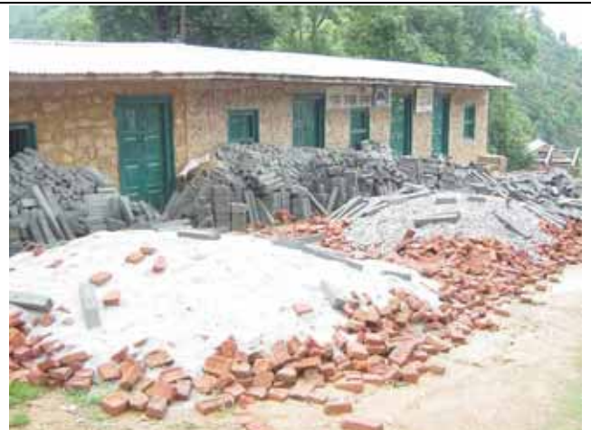
雨で道が悪くなる前に運搬された資材。
