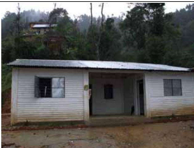
完成した簡易保健所。手前には花壇が作られている。
