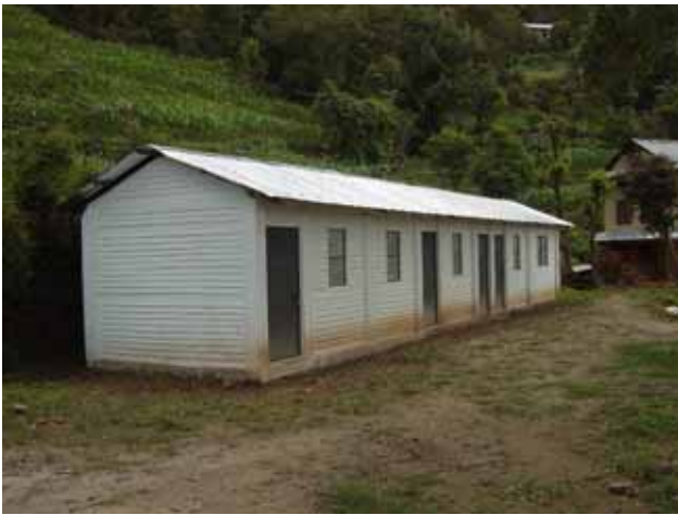
完成後。部屋の移動には外へ出なければならず、利用者は雨などにぬれ、苦情が寄せられていた。
