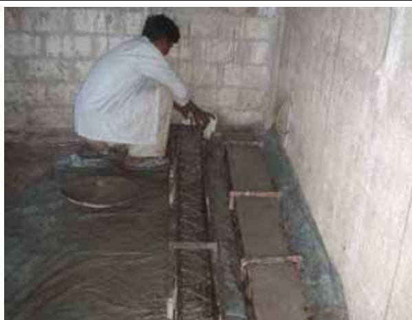
梁を製造している様子。
