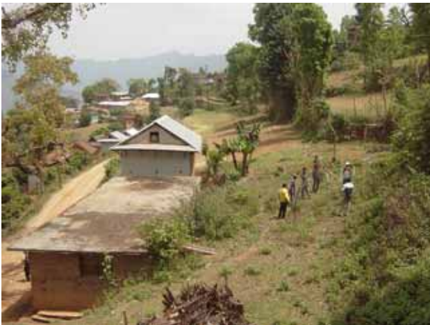
建設地は、村落開発委員会事務所の裏手の空き地に決定した。斜面なので、土地をならすのは大変な作業だったが、住民らが助け合って整備した。
