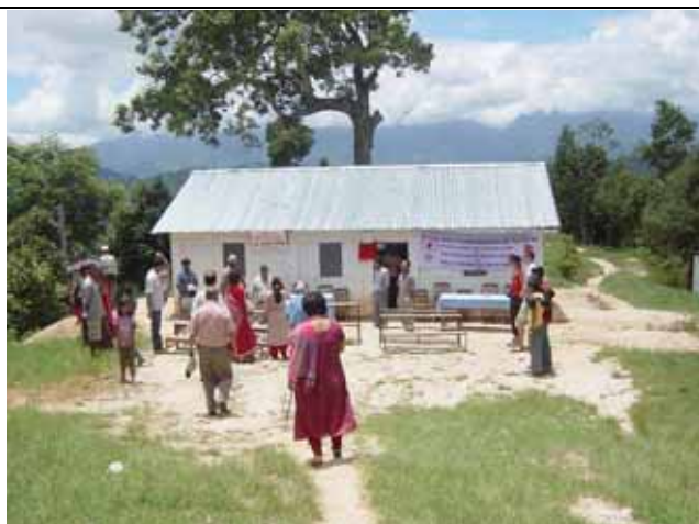
完成した簡易保健所。
