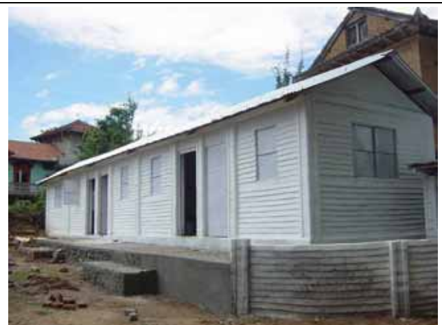
住民がアイデアと労働力を分かち合い、使いやすい保健所に近づいていく。ここは、破壊された村役場跡に建設されたので、床が地面より高い。
