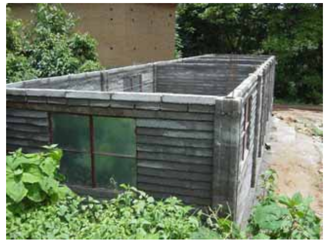
資材が届くと、建設作業はあっという間に進んだ。
