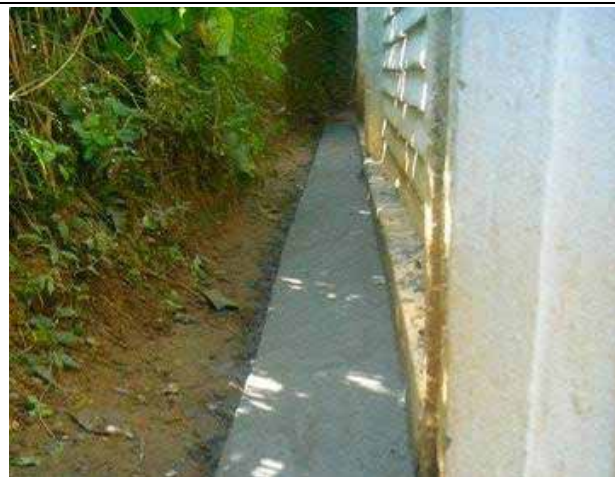
歩きにくかった建物の周りに犬走りを造った。
