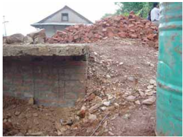
プロジェクト技術者からは注意をされていたのに、便利がいいからと土砂を事務所の裏手の空間に。安全のため、あとで掘り出すことになった。
