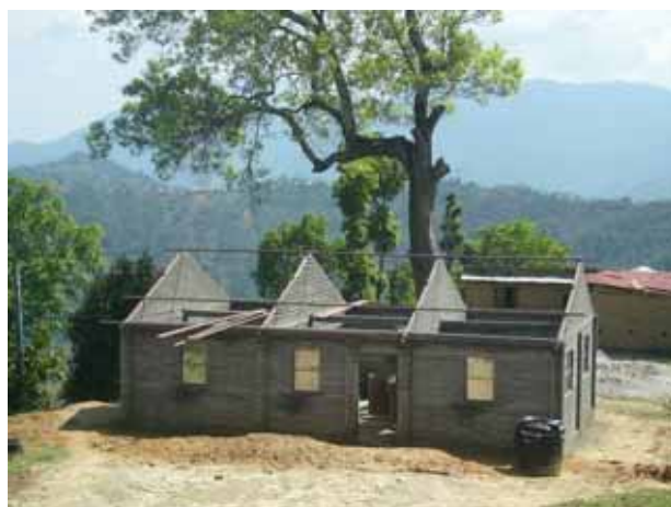
作業中の様子。
